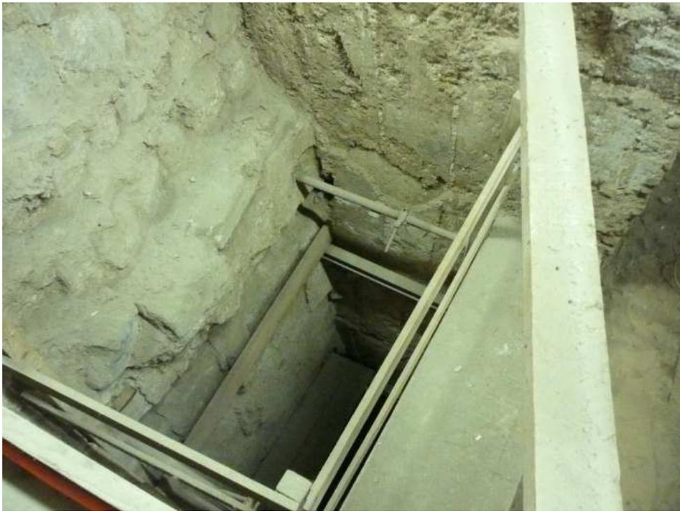
Hier ein etwa zehn Meter tiefes Loch am Fundamentpfeiler des südlichen Turms, das zur Untersuchung der Fundamentsituation gegraben wurde. Die Fundamente des Südturms, der im 14. Jh. begonnen wurde, ragen gut 14 Meter (!) tief in den Baugrund. Neben Steinen hat man auch Zementmörtel und Beton verwendet. Doch das war oft mühselig und langwierig. Man konnte den Beton nicht wie heute maschinell verdichten, sondern musste ihn lagenweise einbringen. Und wenn es dann in der
