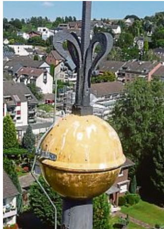
Die Turmspitze ist vom Hubsteiger aus kontrolliert worden.
