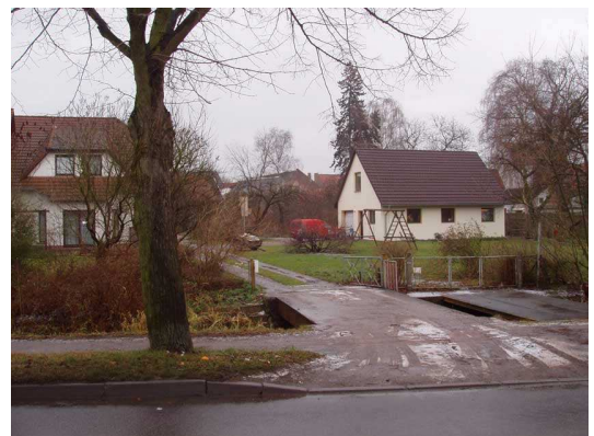
Abb. 1 Das Firmengebäude in Kalbe
